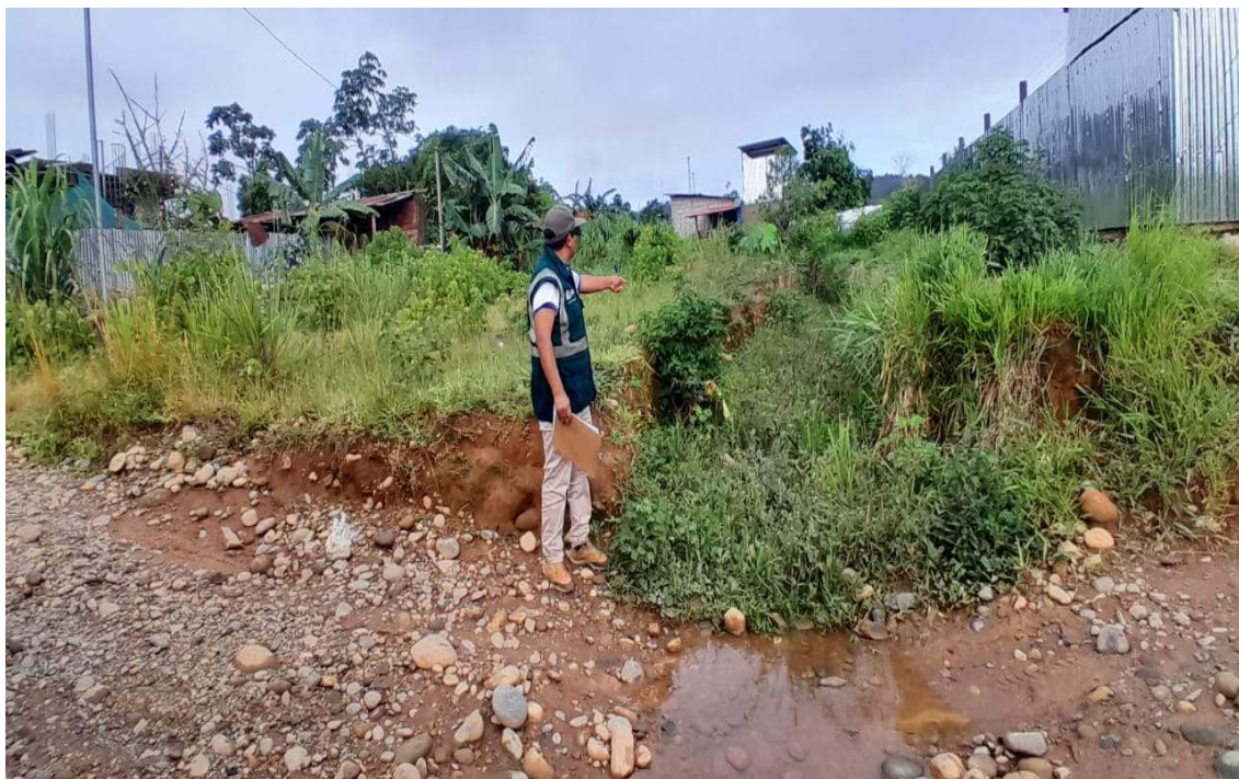
FIGURA N°03: SE APRECIA COLMATACIÓN DEL CAUCE DE LA QUEBRADA MARIANO MELGAR
